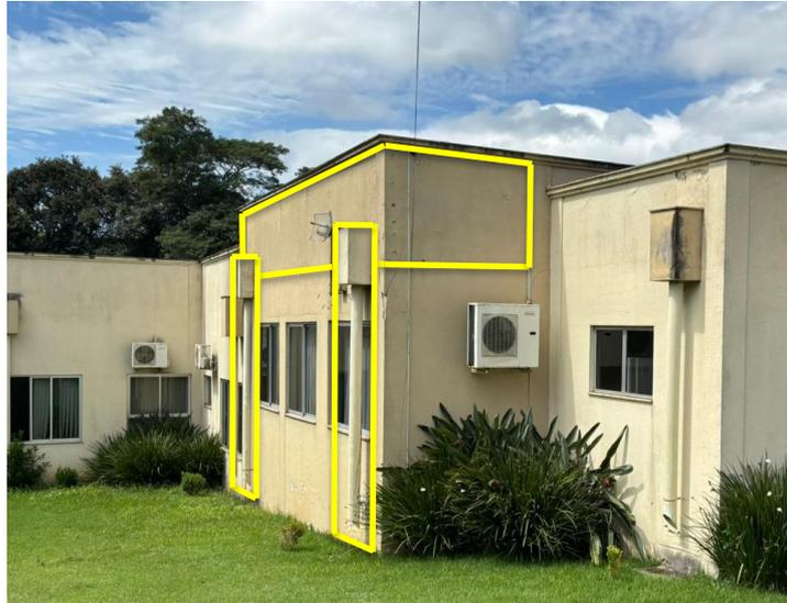
*Figura 7 - Platibanda*
