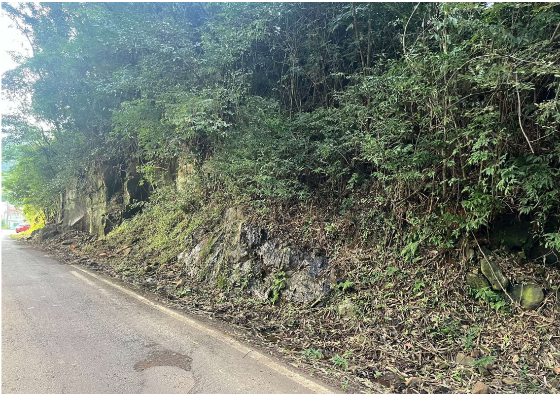
Imagem 03: Identificação maciço rochoso e via;
