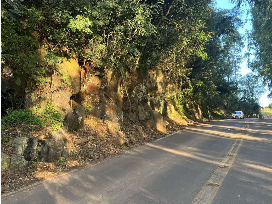
Imagem 04: Identificação maciço rochoso e via;
