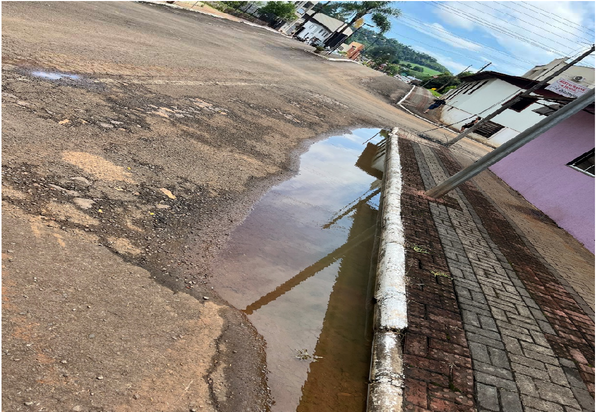
Imagem 31: 19/01/2024 – Nivelamento escoamento água 02 Avenida João Corso
