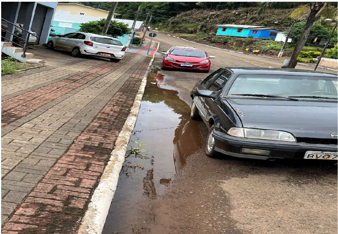
Imagem 32: 19/01/2024 – Nivelamento escoamento água 03 Avenida João Corso
