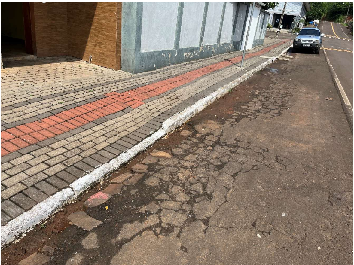
Imagem 33: 19/01/2024 – Nivelamento escoamento água 04 Rua Jacob Corso
