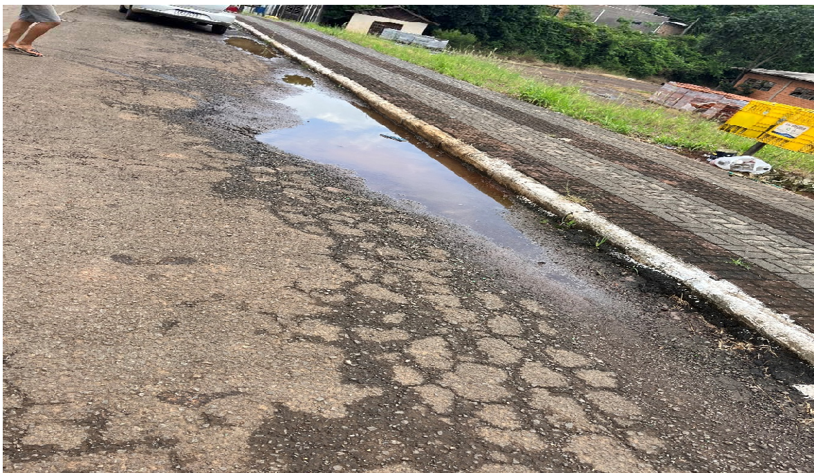
Imagem 30: 19/01/2024 – Nivelamento escoamento água 01 Avenida João Corso
