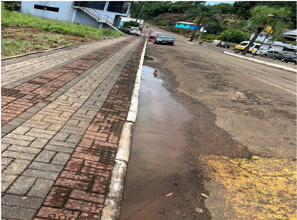
Imagem 31: 19/01/2024 – Nivelamento escoamento água 02 e 03 Avenida João Corso
